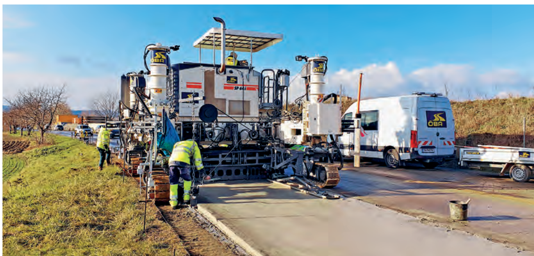
Halbseitiger White- Topping-Einbau mit Betondeckenfertiger
