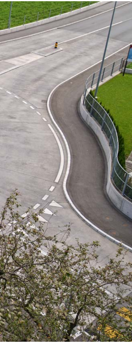
Erster Schweizer Kreisverkehr aus griffigem und lärminderndem Waschbeton in Altdorf, Kanton Uri.
