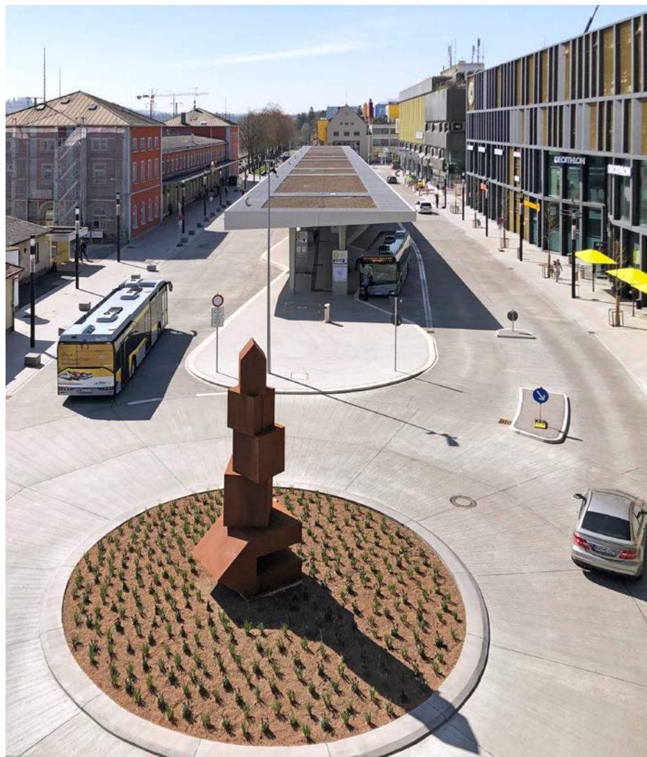
Ein Beispiel für den nachhaltigen Einsatz von Beton im modernen Strassenbau: der stark frequentierte Omnibusbahnhof in Singen (DE). Der Einsatz von Beton sichert hier eine Lebensdauer von mindestens 30 Jahren.
