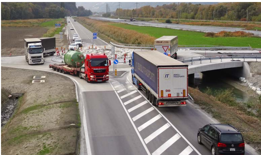
Auf stark beanspruchten Flächen wie Kreisverkehren kommt häufig der langlebige und widerstandsfähige Baustoff Beton zum Einsatz.
