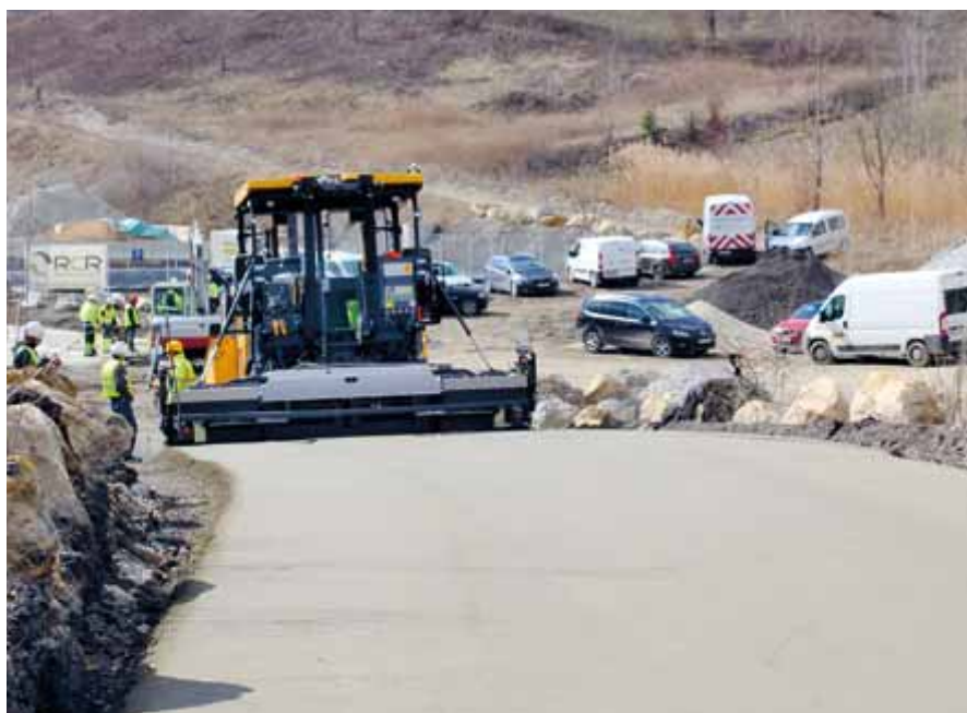
Einbau und Verdichtung des Walzbetons in verschiedenen Situationen
