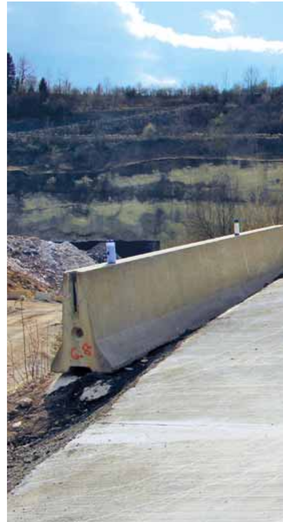
Ein fertiggestelltes Teilstück
