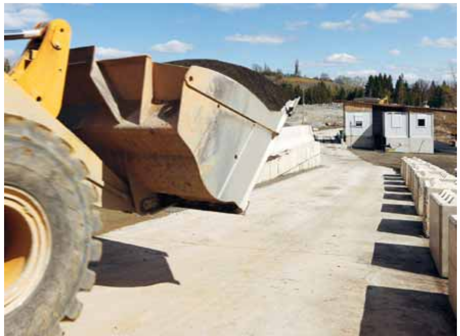
Die Walzbetonstrecke unter Schwerverkehrsbelastung
