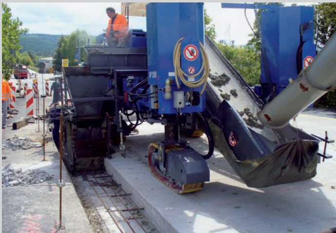
Einbau der Bord-/Rinnenanlage in Bad Sobernheim mit einem Gleitschalungsfertiger Foto: J. Gisdepski
