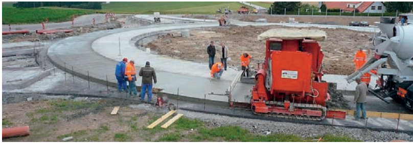
Bau eines Kreisverkehrs in Stapfened, Oberösterreich, mit Gleitschalungsfertiger Foto: Land Oberösterreich
