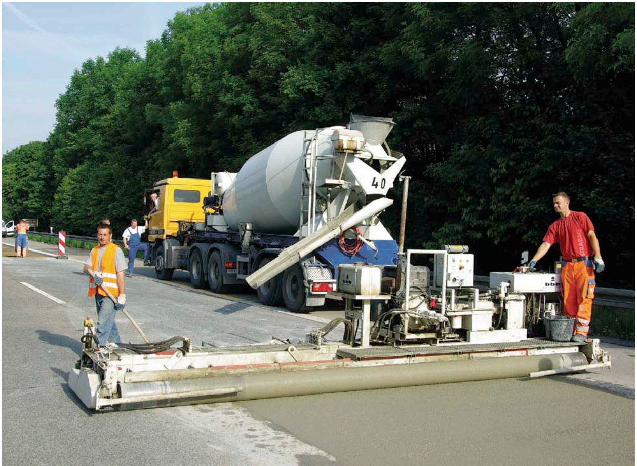
Abbildung 2: Bauliche Erhaltung einer Betonfahrbahndecke (Plattenersatz)
