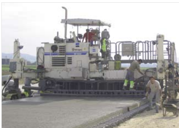
Allgemeine Ansicht während des Betonierens
