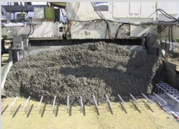
Abb. Nr. 1: Ansicht der Dübel und des Randträgers
