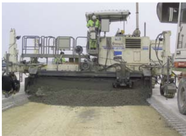
Betonieren eines «Füllstreifens» zwischen zwei bereits betonierten Streifen
