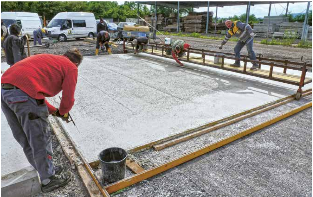
Abbildung 5: Einbau des Betons und Herstellung der Oberfläche (Besenstrich)
